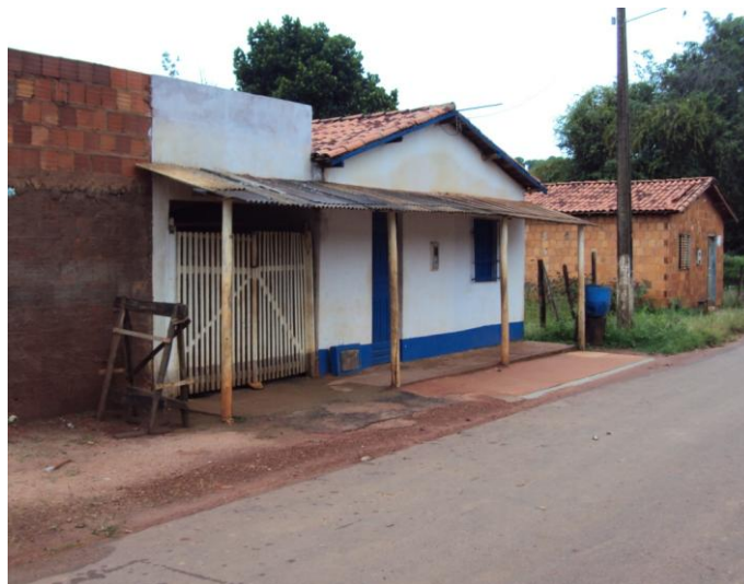
Imagem 05: Alpendre sustentado por madeira de eucalipto
