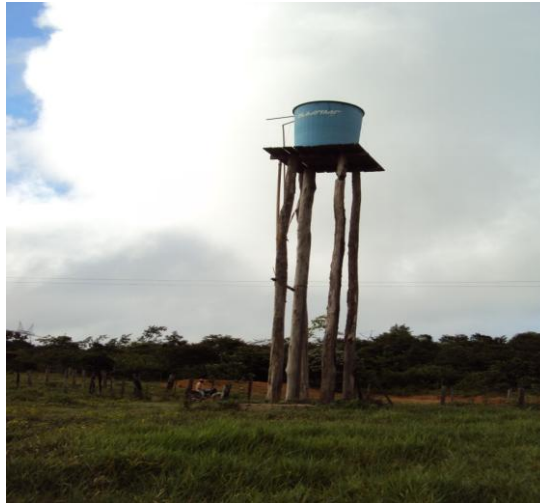
Imagem 04: Reservatório de um dos poços construído pela iniciativa dos assentados.
