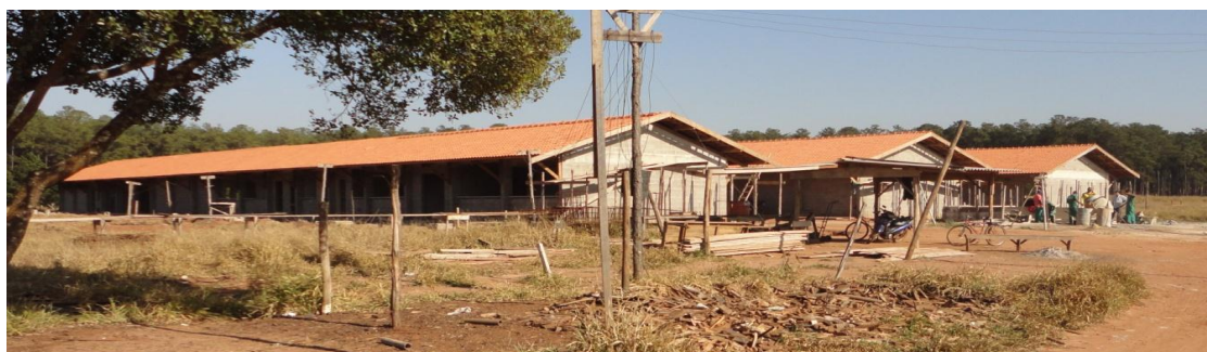
Construção da escola no Assentamento Zumbi dos Palmares em Iaras
